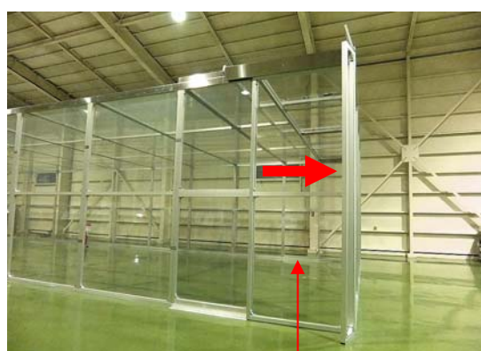
スライドスクリーン フルシャット時 【作業休止時（スリープモード時）】
